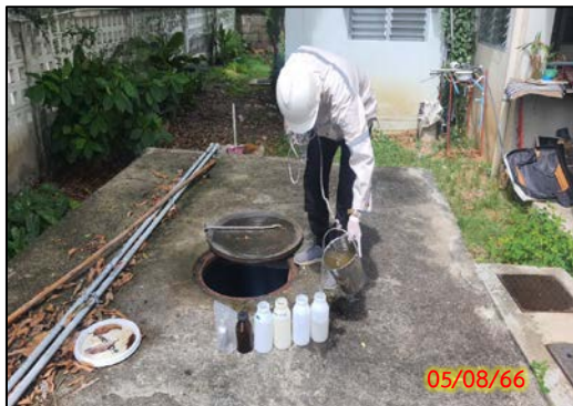
บ่อกักก่อนเข้าระบบบำบัดน้ำเสียประจำอาคาร 2
