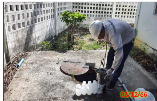
บ่อพักหลังเข้าระบบบำบัดน้ำเสียประจำอาคาร 2
