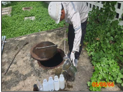
บ่อกักก่อนเข้าระบบบำบัดน้ำเสียประจำอาคาร 1
